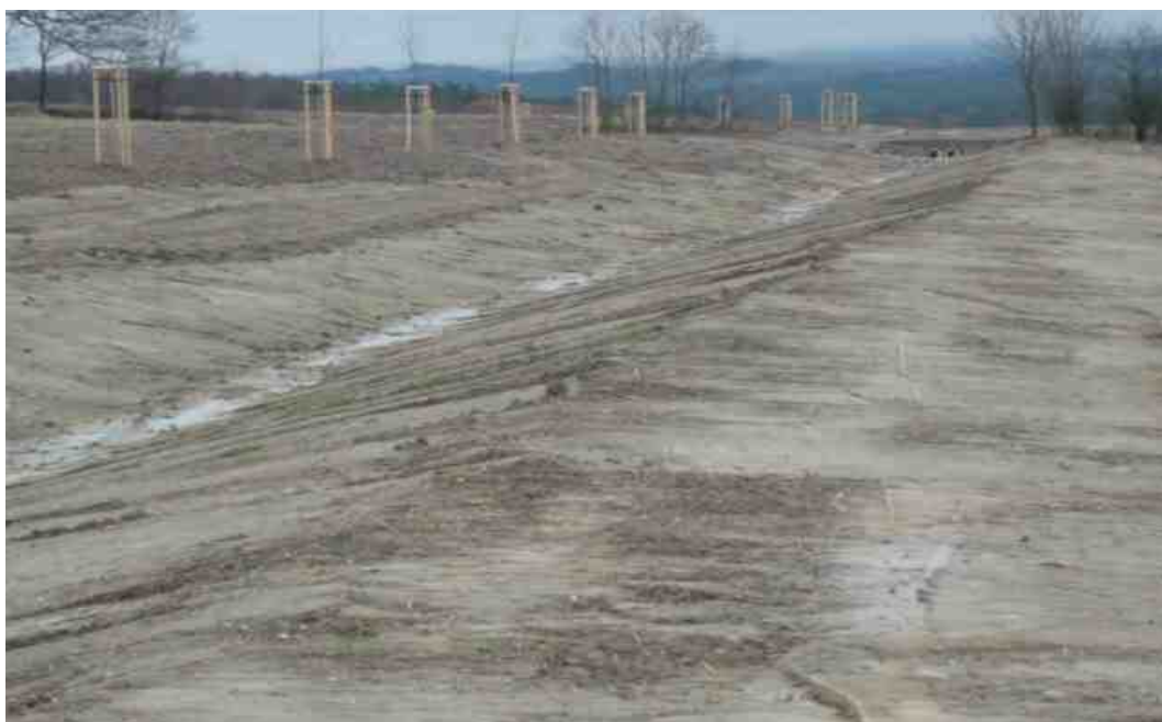
Zasakovací průleh uprostřed svažitého půdního bloku jako ochrana proti bleskovým povodním, které ohrožují zastavěnou část obce, zvyšuje retenci vody v krajině, rozděluje nevhodnou velikost bloku orné půdy a nepřerušenou délku svahu způsobující erozi půdy. (Hromnice Plzeň sever 2014)
